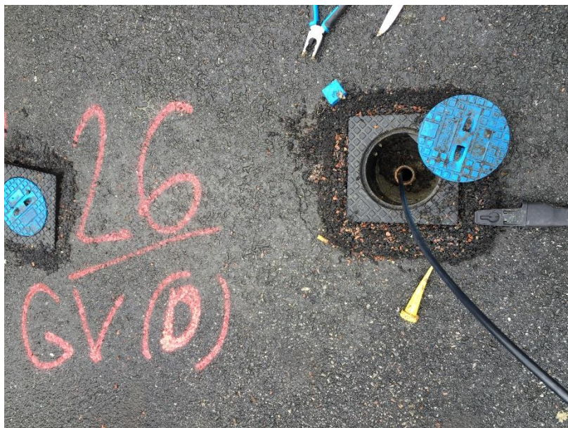
Foto 5: Svart i och runt kvarlämnad slang vid p.26.2.
