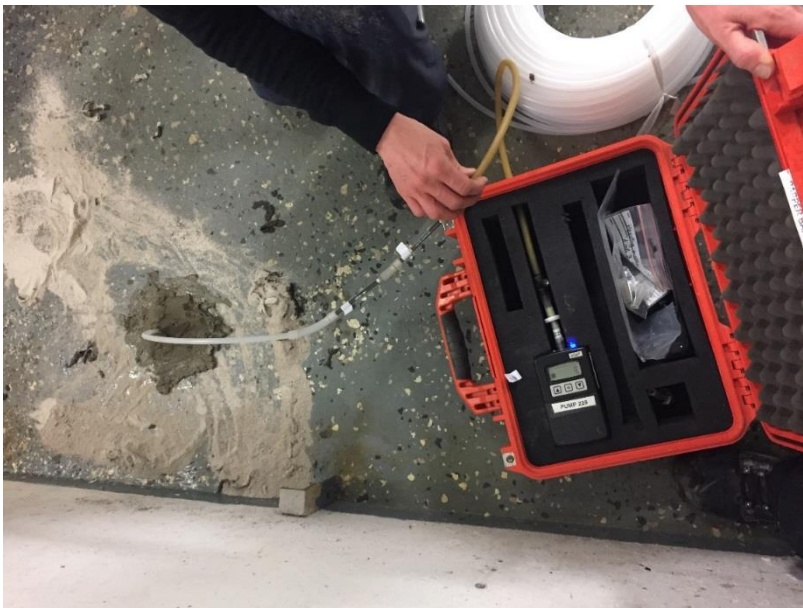
Foto 4: Porluftsmätning under betongplatta.
